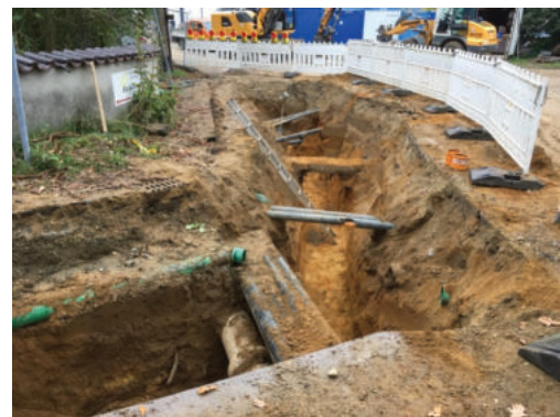
Auf dem Foto: Vorhandene Leitungen im Kurvenbereich nahe der Kapelle. Dieses Bild zeigt so manche Überraschung, die vor Baubeginn nicht bekannt war.
