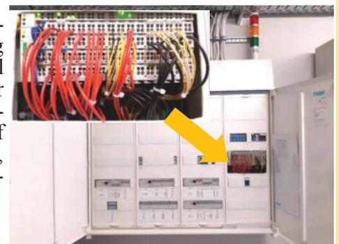
Der zweite Teil des "Gehirns" des Feuerwehrhauses steckt in diesem Schaltschrank im Kommandantenbüro im Obergeschoß. Hier laufen die Informationen aller installierten Sensoren zusammen. Der Schrank enthält die elektronischen Komponenten für:
