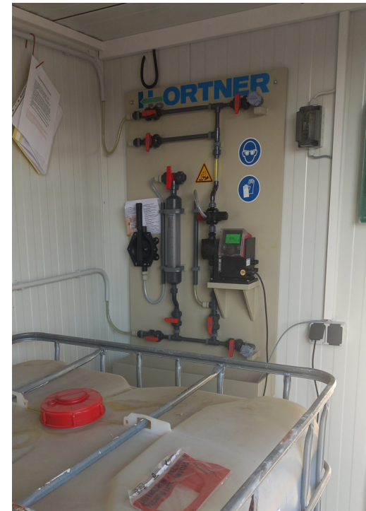
Dosierstation im Lagercontainer
